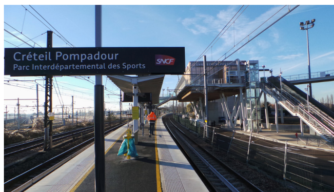
FIGURE 1. – Comme on le voit ici, le quai est très étroit. Téléversé sur Wikipédia par Poudou99 sous licence CC BY-SA 3.0
