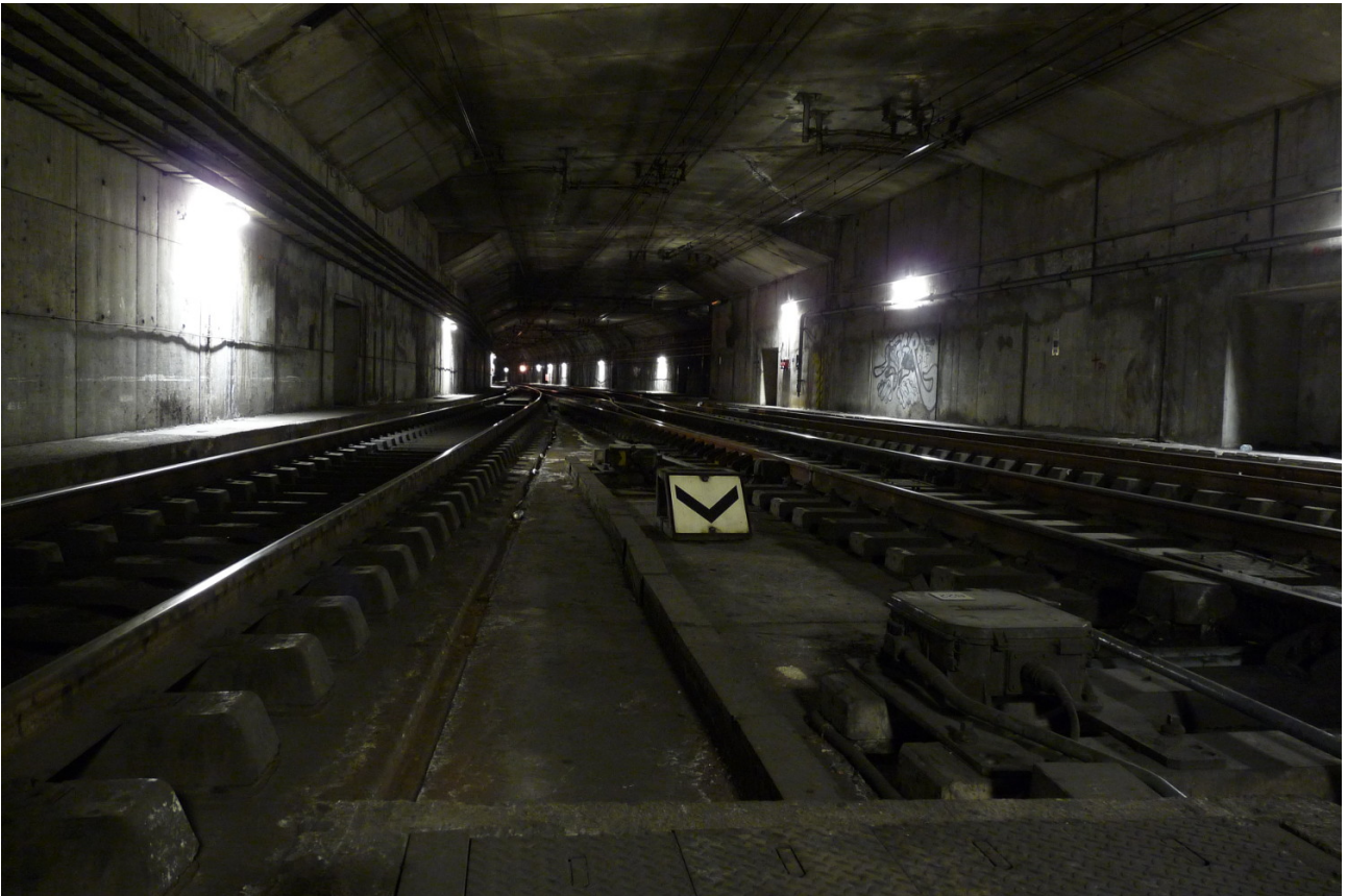
FIGURE 1. – Les voies à la sortie de Gare de Lyon, en direction de Châtelet-les-Halles. Le tunnel est encore unique pour quelques centaines de mètres, avant de se séparer en deux tunnels monotubes.
